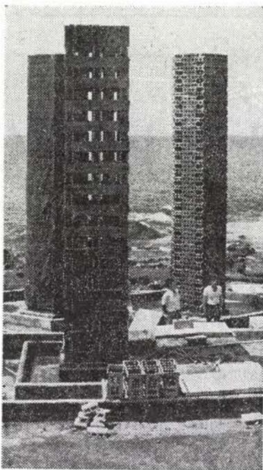
軽重ブロックを積み上げた蒸発塔を使ったタワー式製塩 —伊豆大島間伏海岸で
