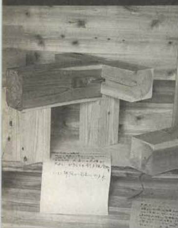
■実物大の軸組模型
